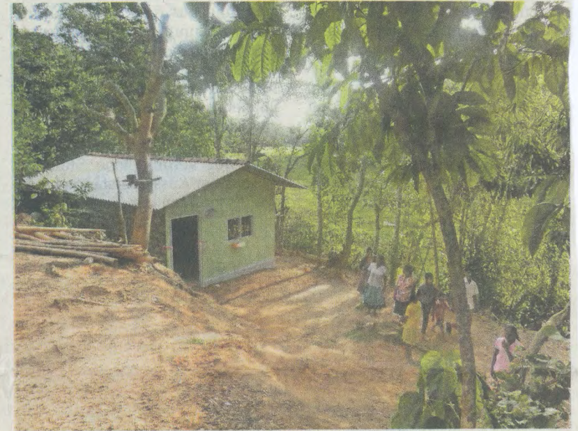
... aus ihrer Blechhütte in ihr gerade fertiggestelltes neues Haus einziehen.
