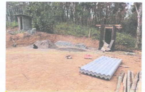
Der Bauplatz für weitere Häuser
